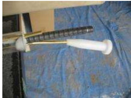
写真 4-23 注入用コーンノズルの干渉抑制
