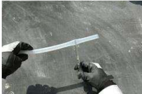
写真 4-5 注入ノズルのカット
