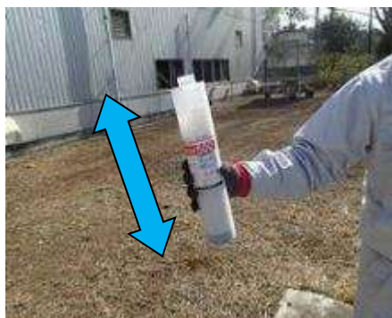
写真 4-8 セメフォースミルクの空振り
