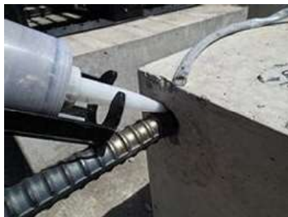
ビニールパイプ取り付けと状態注入
