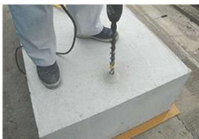
写真 4-1 穿孔(ハンマードリル)
