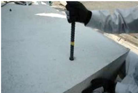
写真 4-19 アンカー筋の埋め込み
