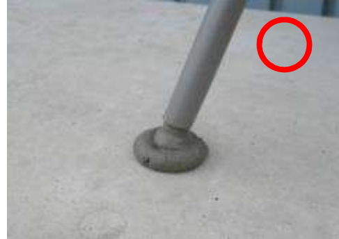
写真 4-16 混合後のアンカー材料(良品)
