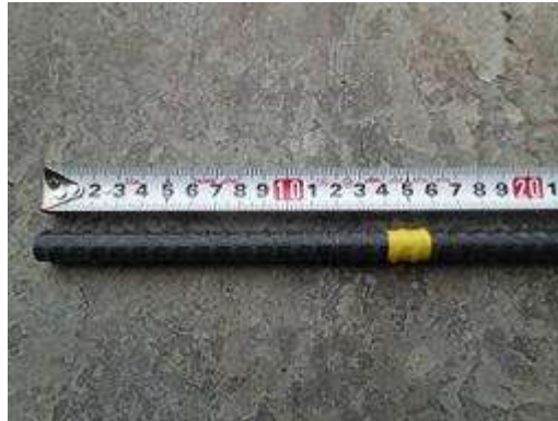
写真 4-7 アンカー筋へのマーキング(埋込み長さの位置)
