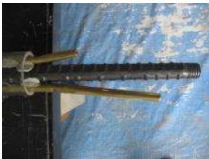
パイプの折り曲げ状態
