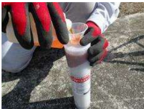
写真 4-9 コーンノズルによる開封
