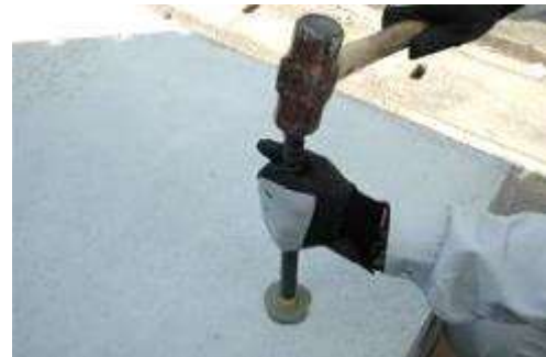
写真 4-19 アンカー筋の埋め込み
