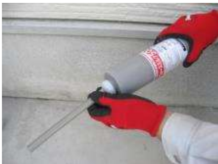
写真 4-20 カートリッジ、ノズルの交換
