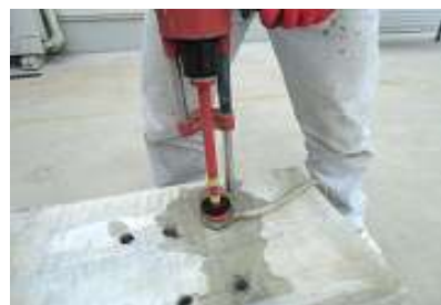
写真 4-2 穿孔(コアドリル)
