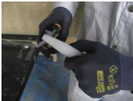
写真 注入用コーンノズルのカット
