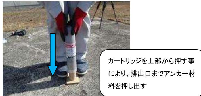
写真 4-13 空押しによるエア抜き
