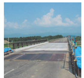
ジベル孔 無収縮モルタル打設完了
