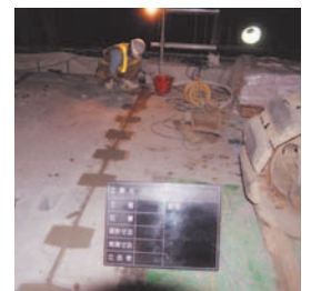
床版継目部 無収縮モルタル打設
