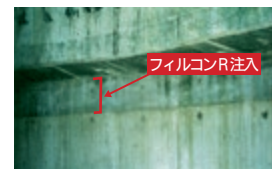
逆打ちモルタル工事
