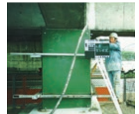
橋脚耐震補強工事
