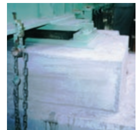
橋梁沓座モルタル
