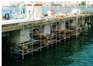
栈橋補修工事
