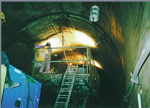
J R東日本 仙岩トンネルにおける施工状況
