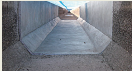
リフレモルセットD施工完了
