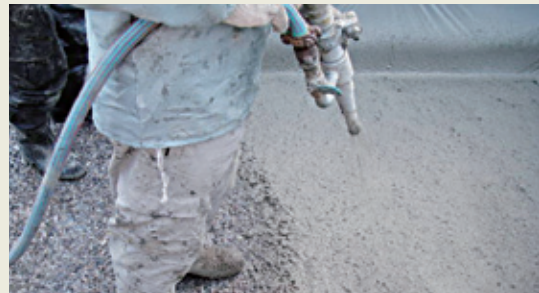
リフレモルセットD吹付け状況
