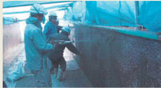
リフレモルセットD吹付け状況
