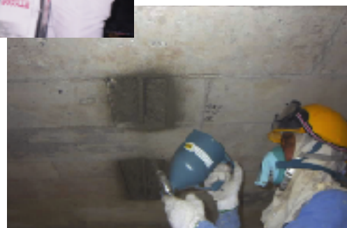
モルタル・コンクリート混和工法 ▶
