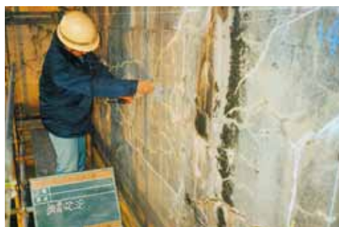
◀ アルカリ骨材反応例
