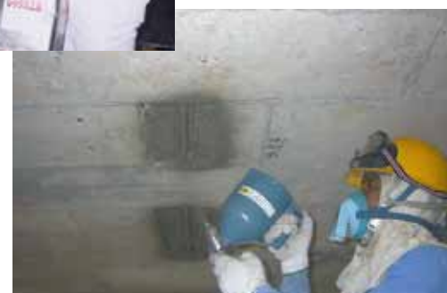
モルタル・コンクリート混和工法 ▶
