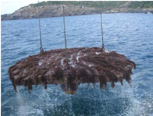
写真3 海藻バンク礁の台船への引き上げ
