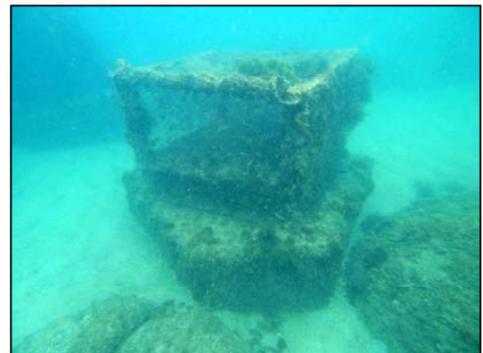
写真2 ネット付き藻場礁設置状況
