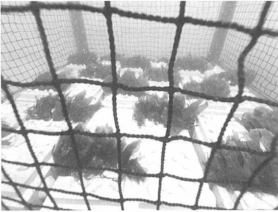
写真13 沈設直後のネット付き藻場礁
