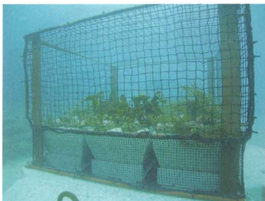
写真9 沈設直後のコンクリート藻場増殖礁
