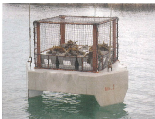
写真8 沈設作業中のコンクリート藻場増殖礁
