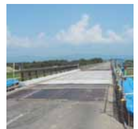
ジベル孔 無収縮モルタル打設完了
