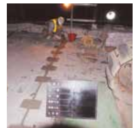
床版継目部 無収縮モルタル打設
