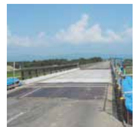
ジベル孔 無収縮モルタル打設完了
