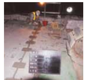
床版継目部 無収縮モルタル打設
