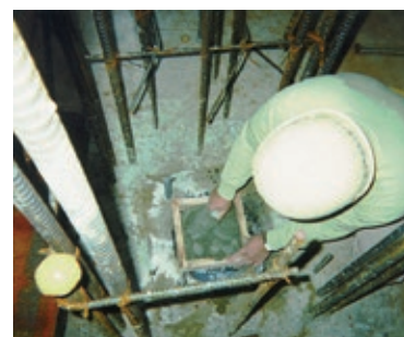
鉄骨柱基礎ベースモルタルの施工状況
