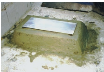
機械基礎/パッドの施工状況
