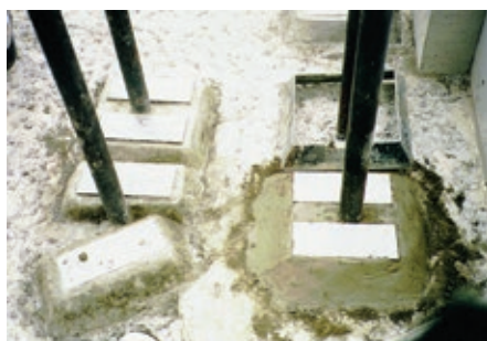
機械基礎/パッドの施工状況
