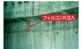
逆打ちモルタル工事
