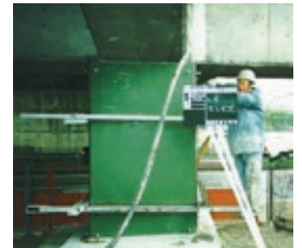
橋脚耐震補強工事
