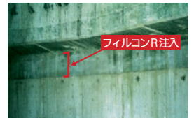
逆打ちモルタル工事
