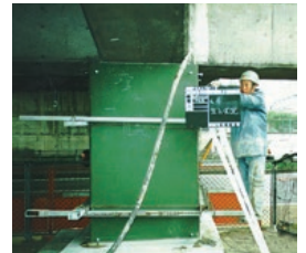
橋脚耐震補強工事
