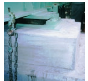
橋梁沓座モルタル
