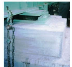
橋梁沓座モルタル
