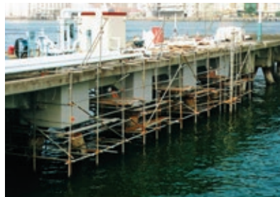
栈橋補修工事
