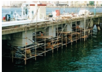
栈橋補修工事
