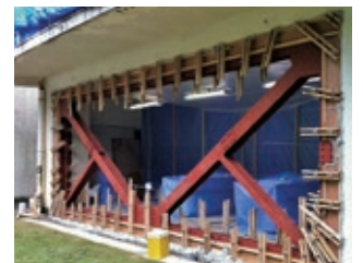
耐震補強充填工事
