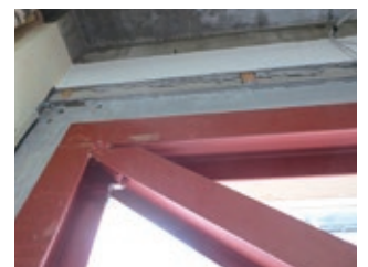
耐震補強充填工事
