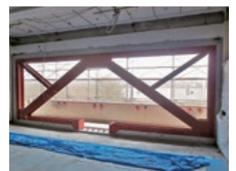
耐震補強充填工事
