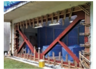
耐震補強充填工事
