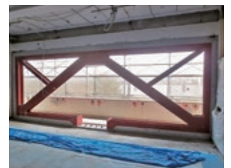
耐震補強充填工事
