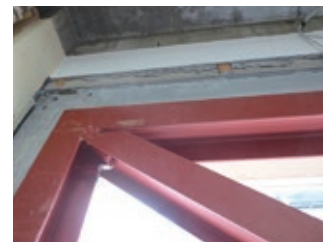
耐震補強充填工事
