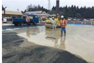
施工中（セメントミルクの散布・浸透）
