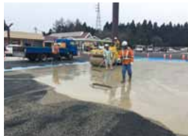
施工中 (セメントミルクの散布・浸透)
