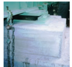
橋梁沓座モルタル
