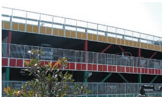
立体駐車場のスラブコンクリート
