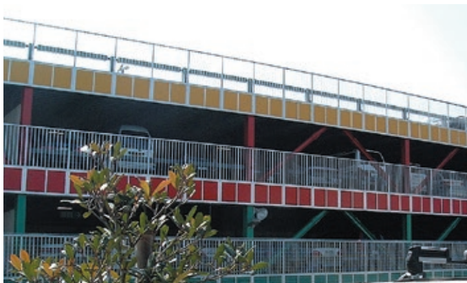
立体駐車場のスラブコンクリート
