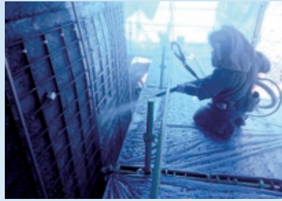
橋脚耐震補強
