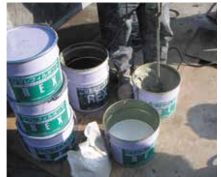
リフレフィルボンド混練状況
