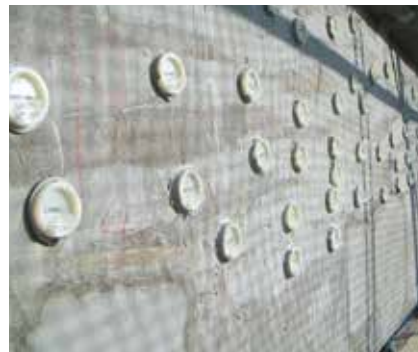
シール及び注入器具取付状況
