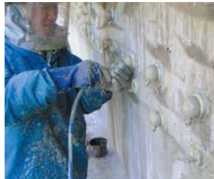
リフレフィルボンド注入状況
