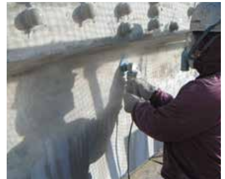
注入器具及びシール材撤去状況
