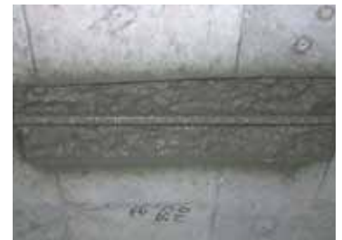
α防錆ペーストの塗布完了(塩害対策工法)
