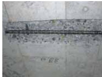
α防錆ペーストの塗布(塩害対策工法)
