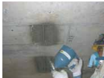
α防錆ペーストの塗布(塩害対策工法)
