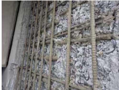
α防錆ペースト鉄筋塗布後状況
