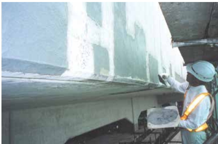
▲ 埋め戻し状況
