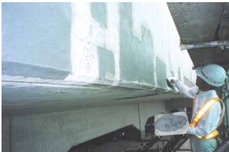
▲ 埋め戻し状況
