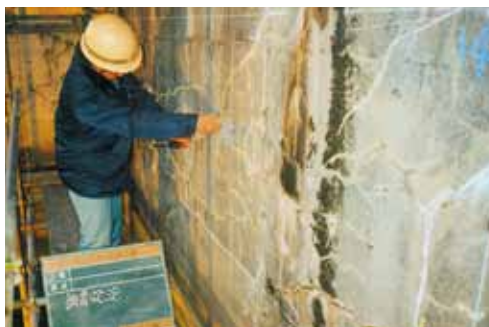
◀ アルカリ骨材反応例
