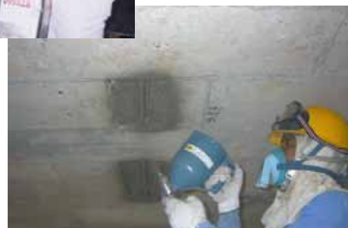
モルタル・コンクリート混和工法 ▶
