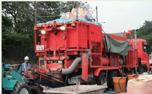
モービル車による大規模施工事例
