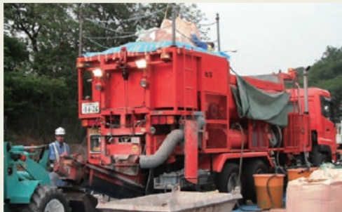
モービル車による大規模施工事例
