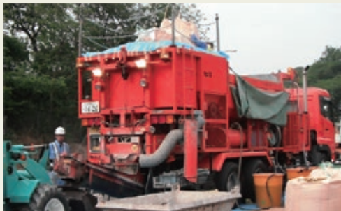
モービル車による大規模施工事例
