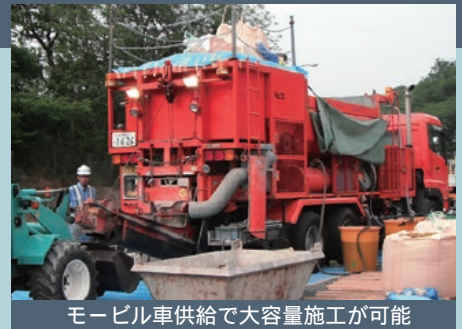
モービル車供給で大容量施工が可能
