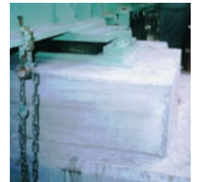
橋梁沓座モルタル
