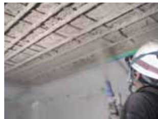
リフレGショットの吹き付け
