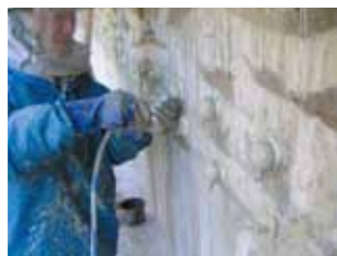
リフレフィルボンドの注入
