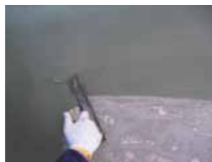
リフレベースパテの塗布
