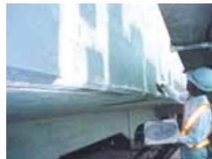
リフレモルセットの埋め戻し
