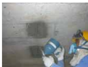
α防錆ペーストの塗布
